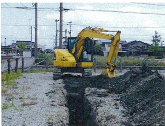
埋め戻し状況（南から）
