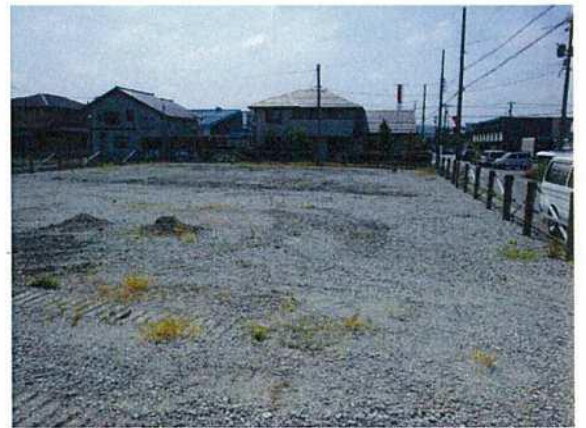
埋め戻し後（東から）
