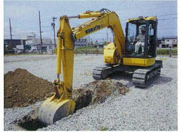
トレンチ掘削（南から）
