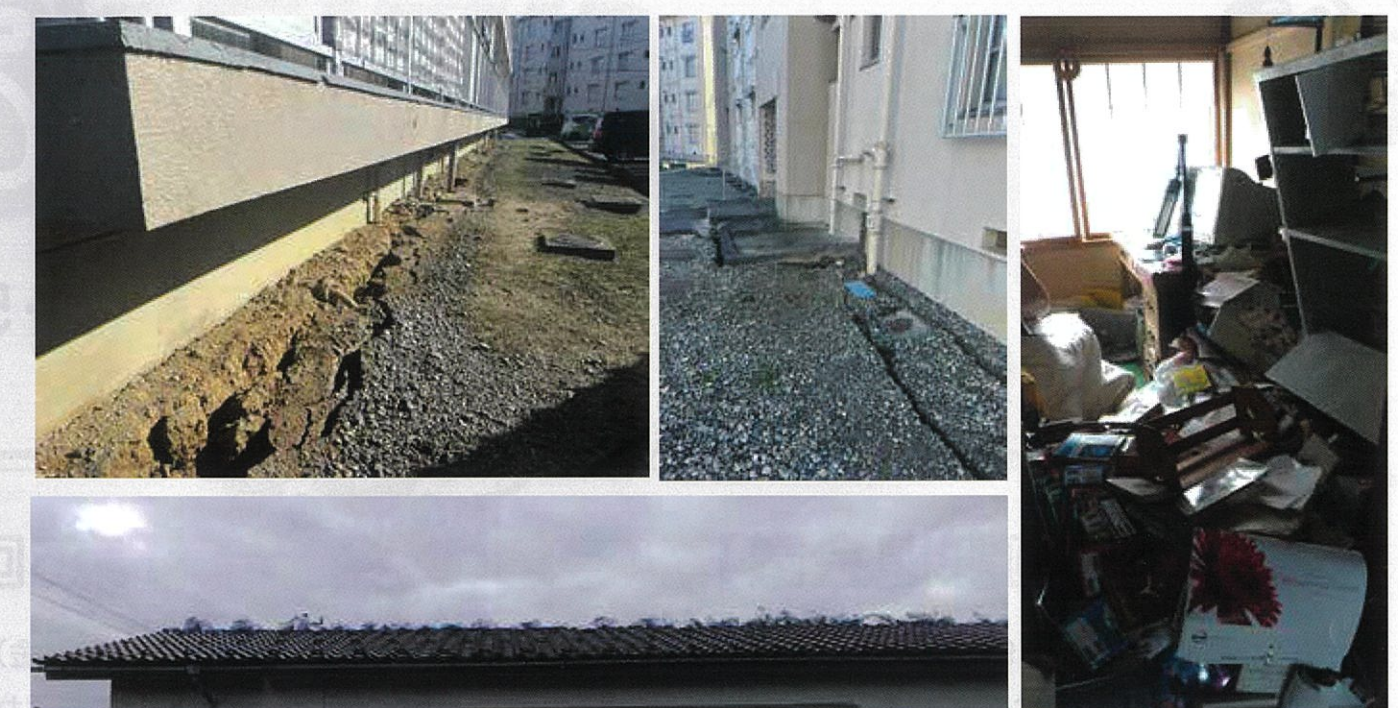
アパート・住宅に関しては、土地の沈下や液状化、ブロック塀や灯籠の崩壊、断水(水道管傷)、家具や食器等の破損・散乱、屋根瓦の破損など・・・
