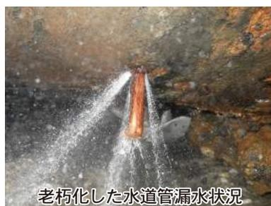
老朽化した水道管漏水状況
