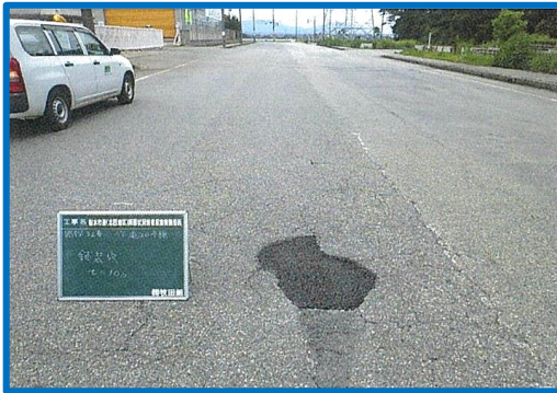
異常箇所 舗装補修後
