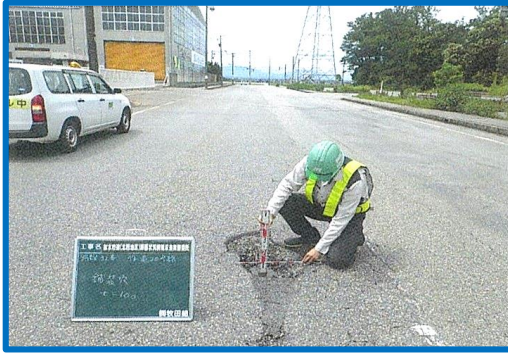
道路パトロール 異常箇所確認
