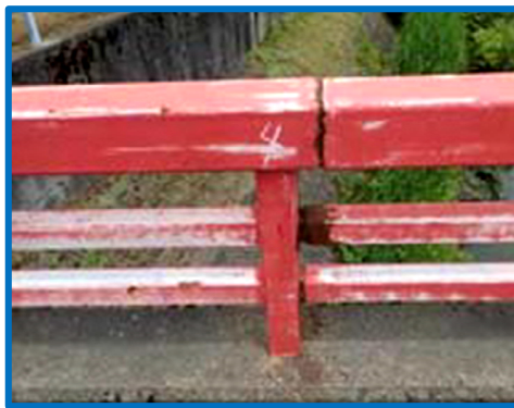
塗替え塗装工
