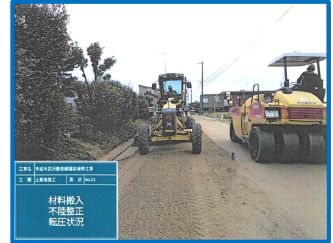
上層路盤工施工中
