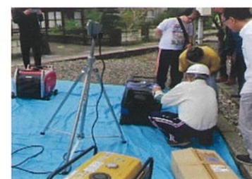
<非常用発電機の駆動・点灯>
