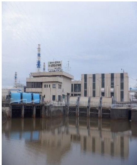
東部排水機場
