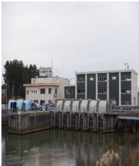
西部排水機場
