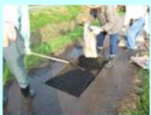
農道の部分補修
