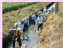
水路の泥上げ
