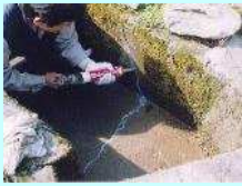
水路のひび割れ補修
