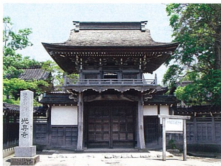
【有形文化財：建造物】
