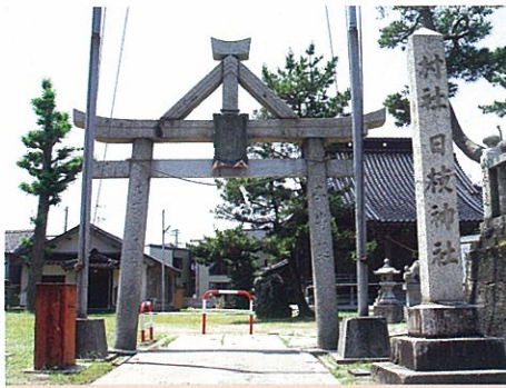
【有形文化財：建造物】
