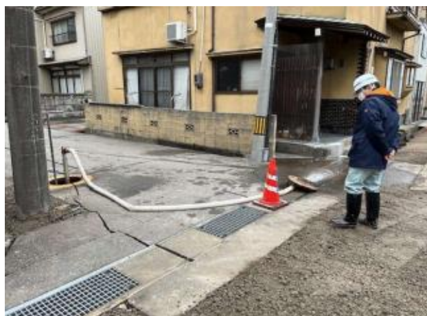
公道本管修繕 (港町地内)
