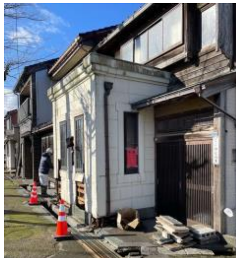
被災建築物応急危険度判定の様子
