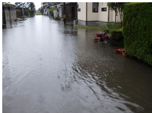
写真 浸水被害状況（平成30年10月 小島地内）
