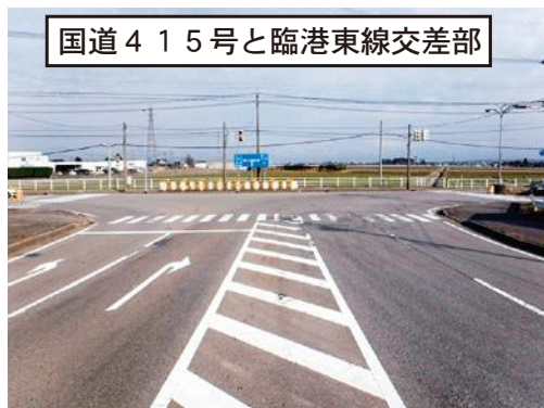
射水市側より
