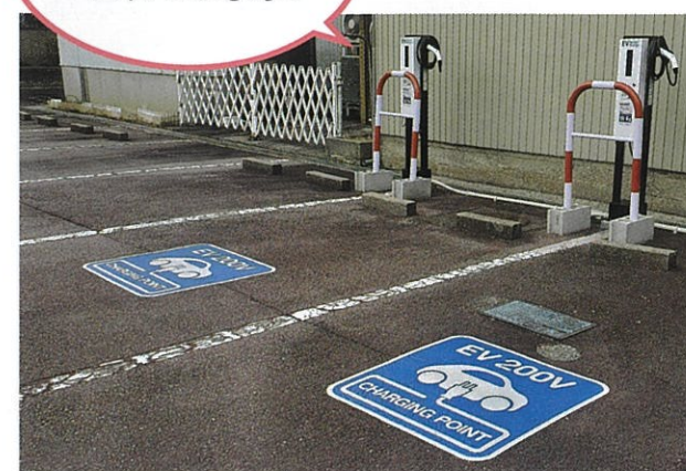
大門コミュニティセンター駐車場北側
