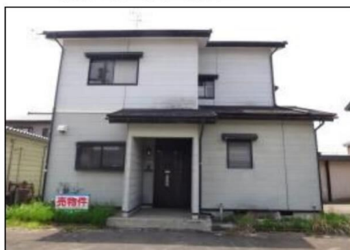
目立った損傷なし
