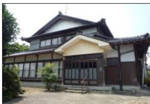
目立った損傷なし
