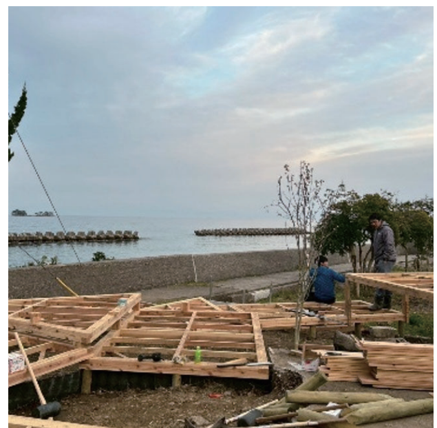
写真 15. 低いレベルから組み上げられたフレーム
