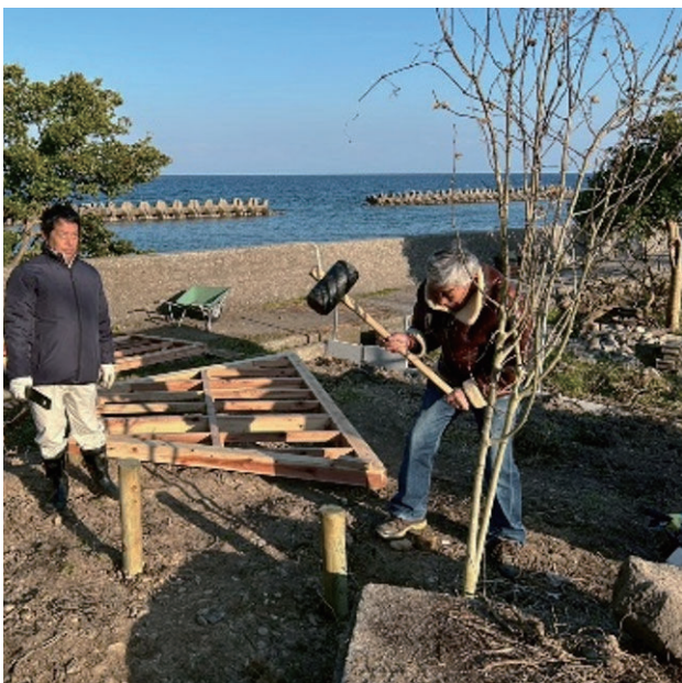
写真 14. 杭打ちをする山本区長
