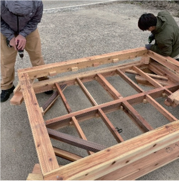
写真 12. 現場での組み立て作業
