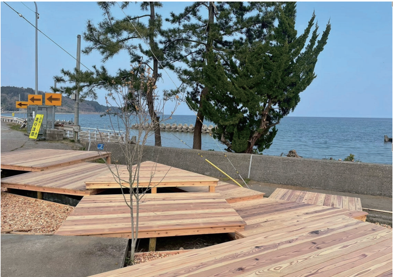
写真 18. 竣工した「アブガシマテラス ver. 1.0」
