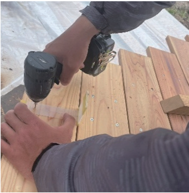
写真 16. ジグを用いた床板貼り
