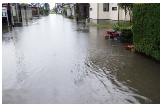
大島地区（小島排水区）浸水状況
